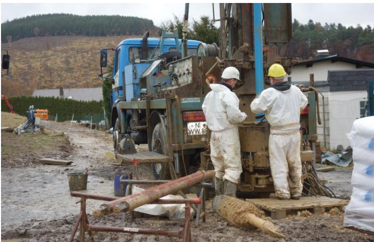
Brunnenbau auf dem Werksgelände
