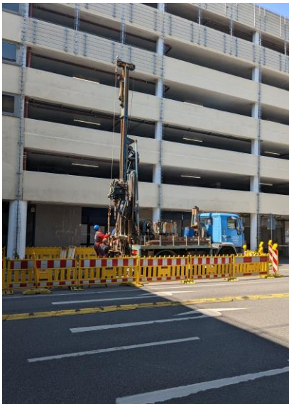
Messstellenbau in der Straße „Reichensand“
