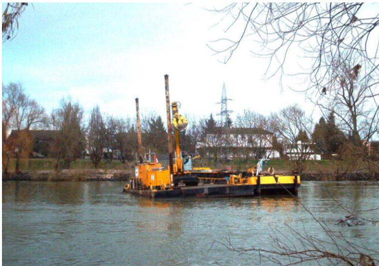
Anfahrt Pontonverband für Mainufer - Sanierung in Mühlheim
