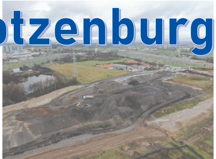
Abb.: Zustand der Deponieoberfläche Ende 2023 (Blickrichtung nach Osten)
