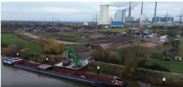
Großkrotzenburg, Deponie Eisert: Gelände und Schiffsanleger
