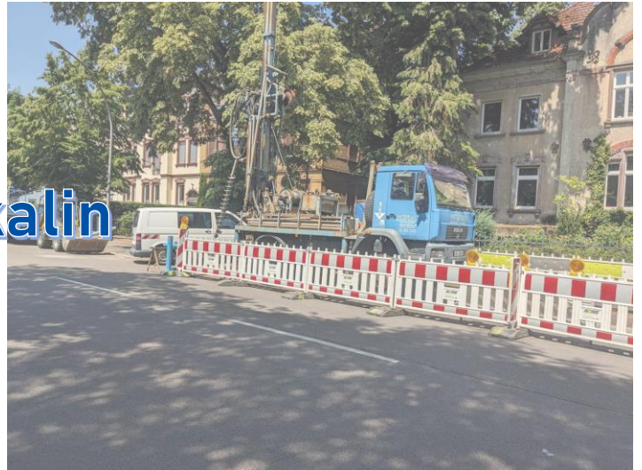
Messstellenbau in der Frankfurter Landstraße
