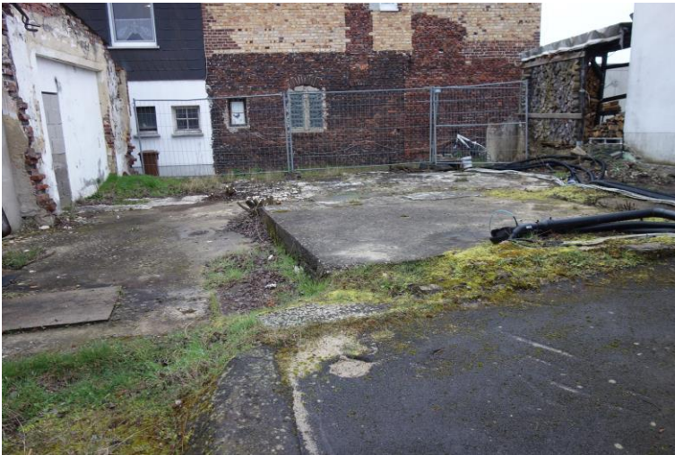
Ehemaliger Betriebsstandort nach Gebäuderückbau
