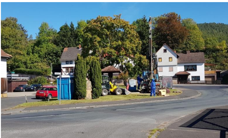
Messstellenbohrung im Ort Richelsdorf
