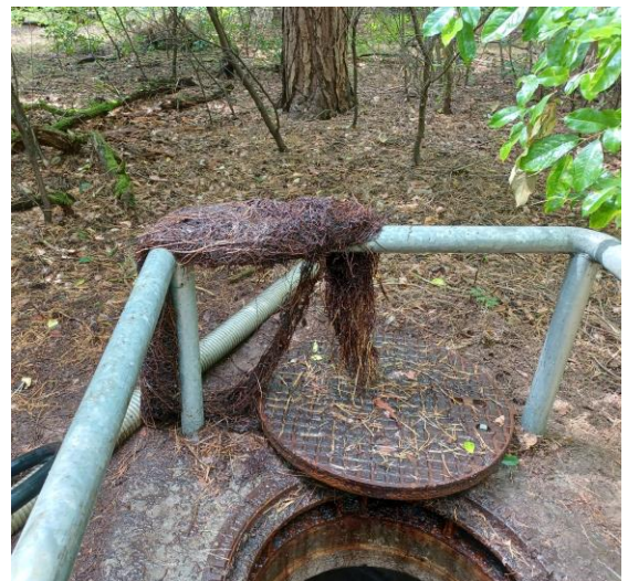
Entfernte Wurzeln aus Infiltrationsbrunnen
