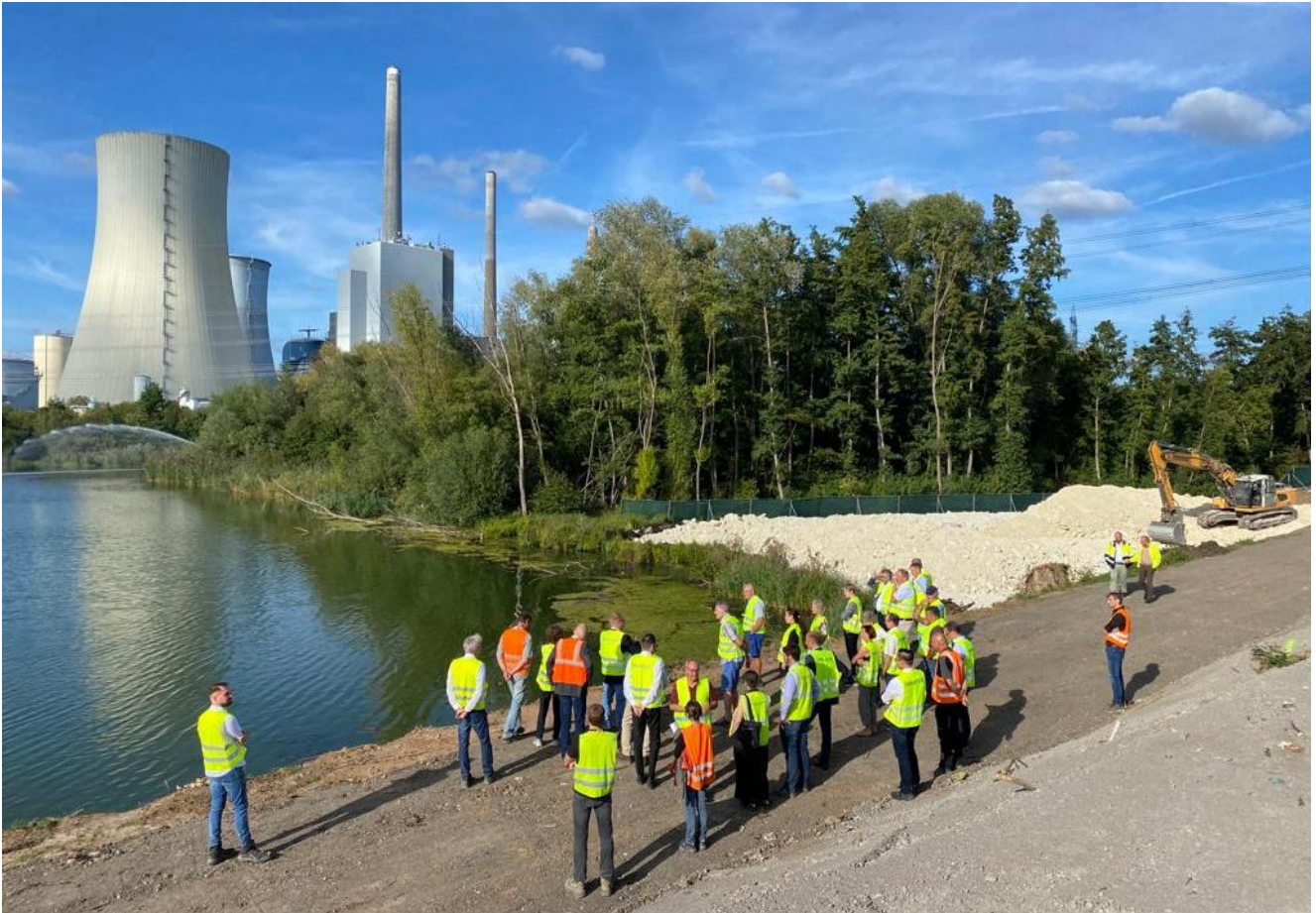
Baustellenbegehung anlässlich des Besuchs von Staatssekretär Conz in Großkrotzenburg (Quelle: HMLU)
