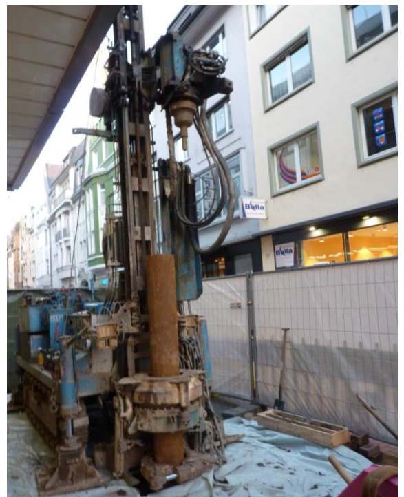
Messstellenbau in der Straße „Seltersweg“ (Fußgängerzone)
