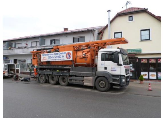
Leitungsreinigung bei der Anlage „Fahnenmitte“
