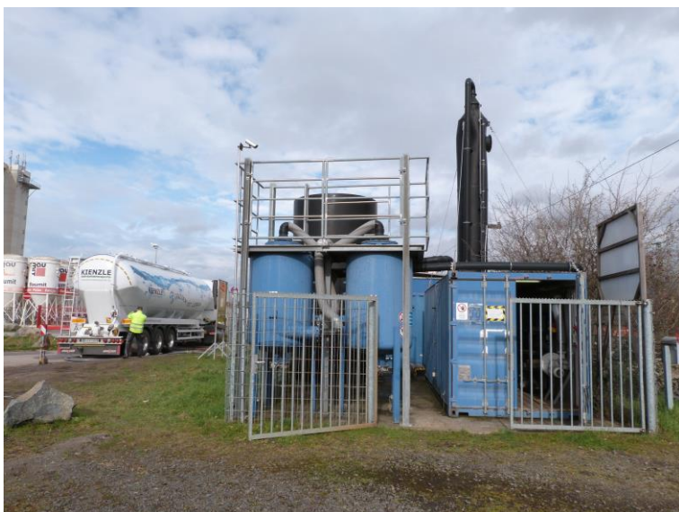
Aktivkohlewechsel bei der Anlage „Fahnenspitze“
