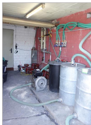
Bodenluftabsauganlage und Bodenluftpegel mit paralleler Wasserfassung (Stand 2023)
