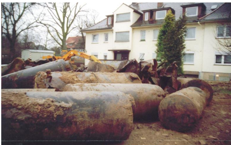
Bergung der eingelagerten Erdtanks (1993)
