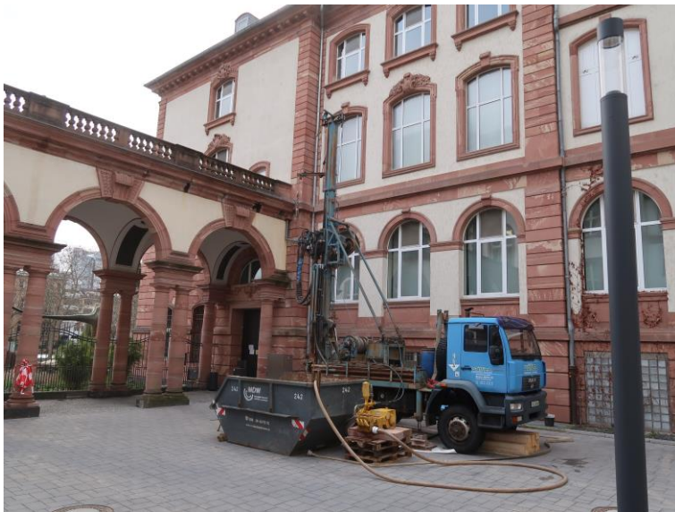
Errichtung der GWM 26 im Innenhof des Senckenbergmuseums
