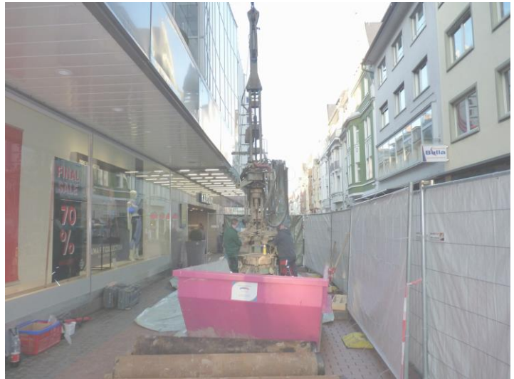
Errichtung einer Grundwassermessstelle in der Fußgängerzone
