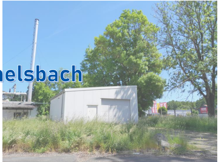
Leichtbauhalle der Grundwasserreinigungsanlage
