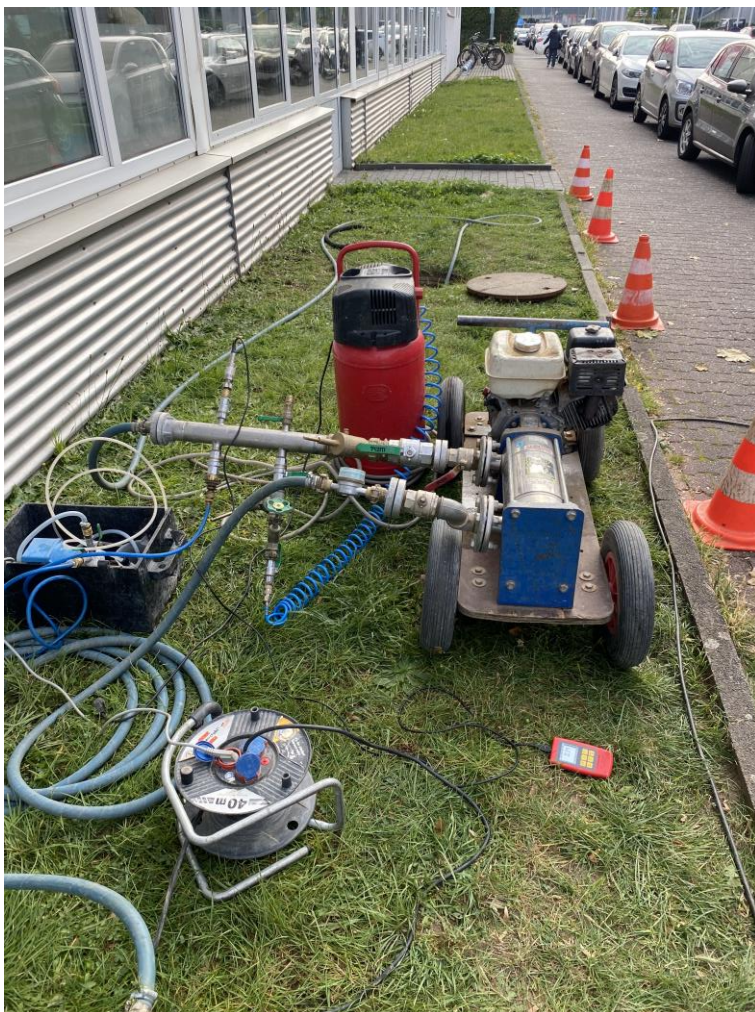
Leitungspülung zur Erhöhung der Förderleistung
