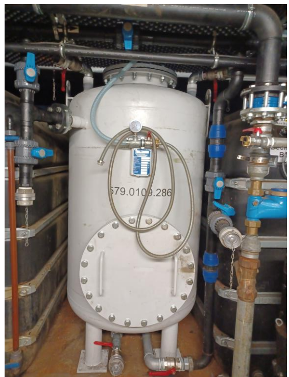
Neuer Wasseraktivkohlefilterbehälter
