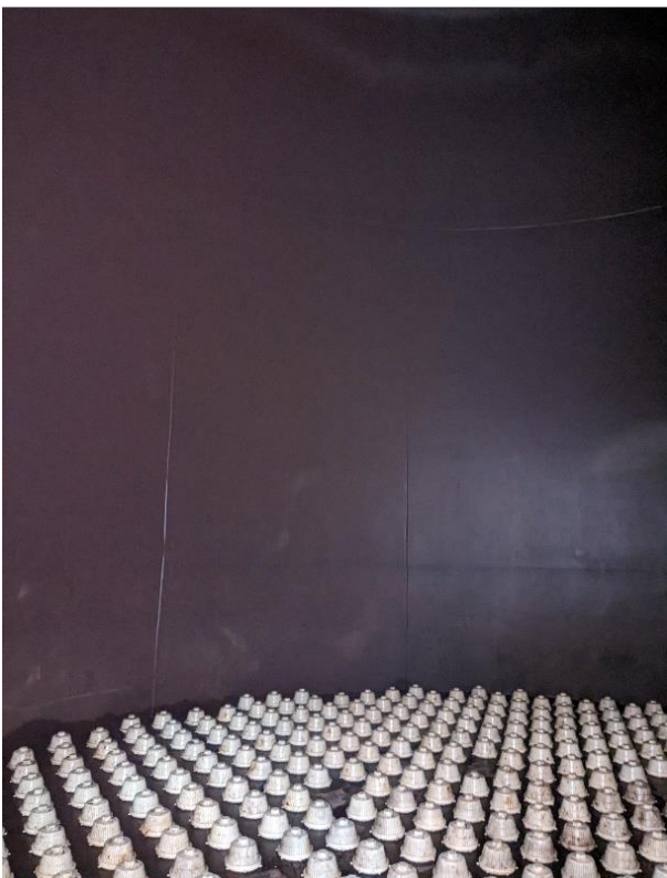
Blick in die Aktivkohlefilter A1 und B1
