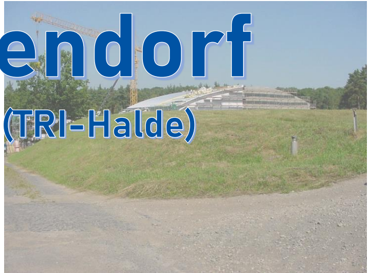
TRI-Halde mit Einhausung für Bodenabtrag (2003-2004)
