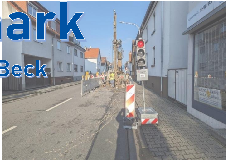
Bohrgerät in Straßensperrung (GWM-Bau 2023)
