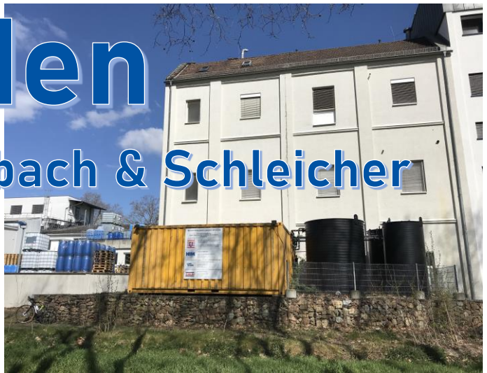
Anlagenstandort zwischen der Liegenschaft und dem Rheinufer
