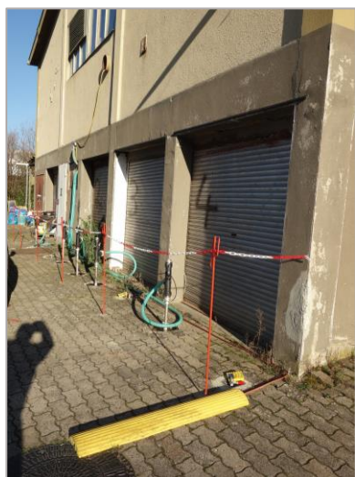
Bodenluftabsauganlage und Bodenluftpegel mit paralleler Wasserfassung (Stand 2023)
