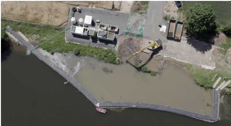
Pontonanlage zur Sanierung des Ederufers in Edermünde-Grifte
