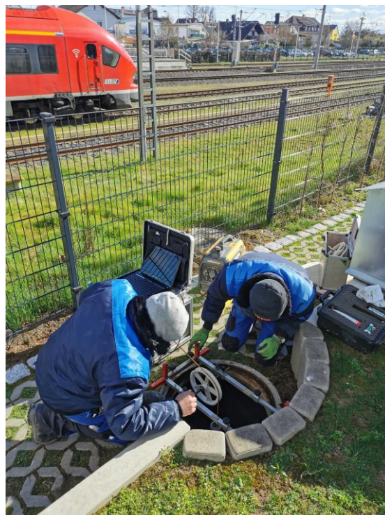
Kamerabefahrung des Sanierungsbrunnens SAN 2 (2023)
