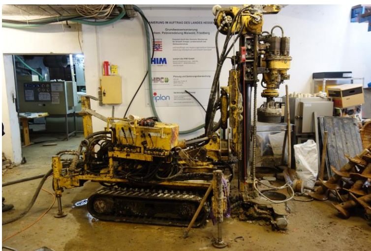
Spezial-Bohrgerät zur Errichtung von GWM innerhalb der ehemaligen Betriebsgebäude
