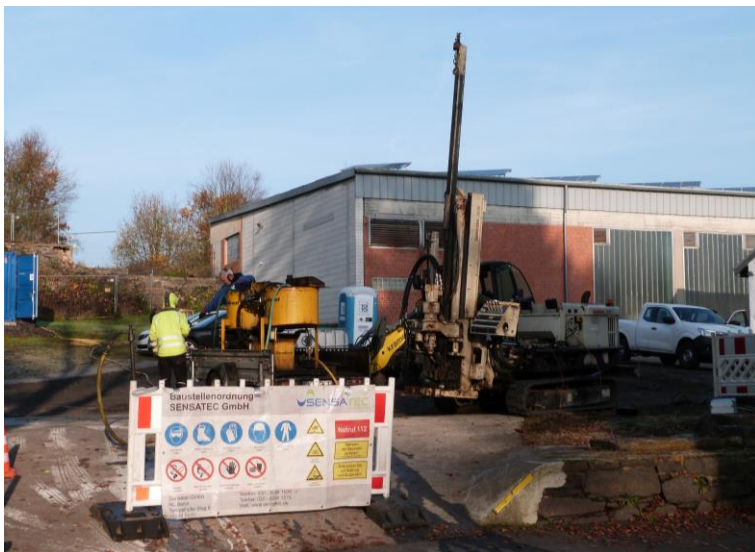
Bohrgerät Injektion Biostimulation
