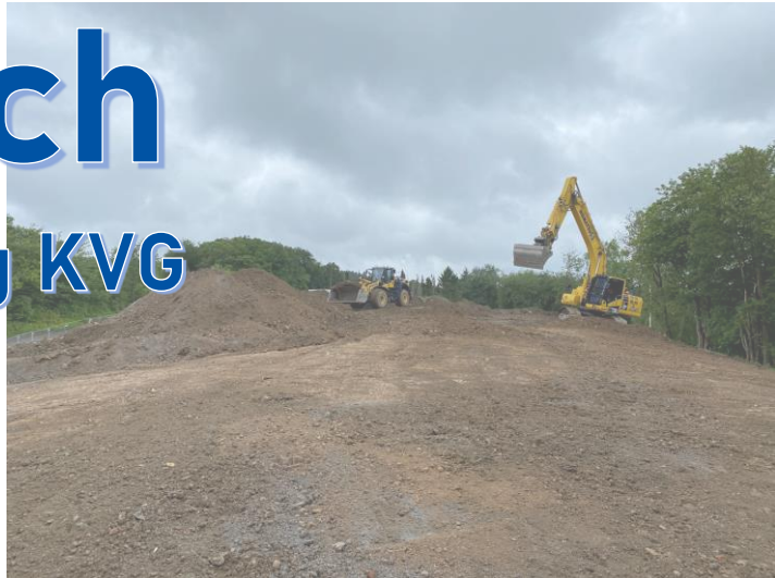
Profilierungsarbeiten zum Bau des Abdichtungssystems
