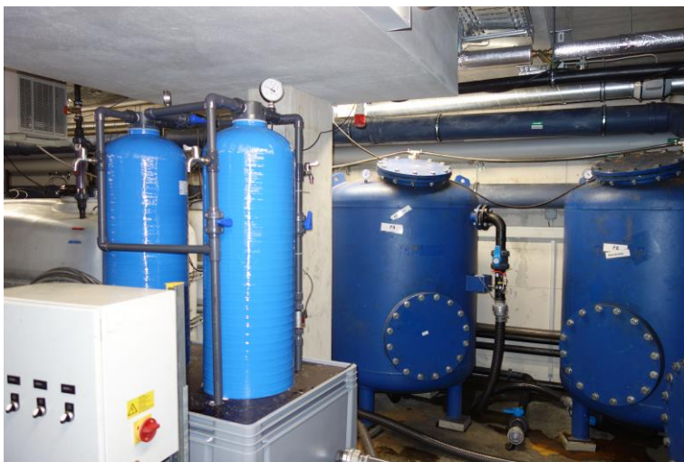
Patronenanlage (Ionentauscher) zur optimierten Chromat-Abreinigung (Pilotversuch 2023)
