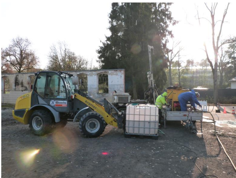
Vorbereitung Injektion Biostimulation
