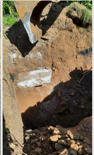
Baggerschurf im Bereich des ehem. Gleisanschlusses mit Streifenfundamenten
