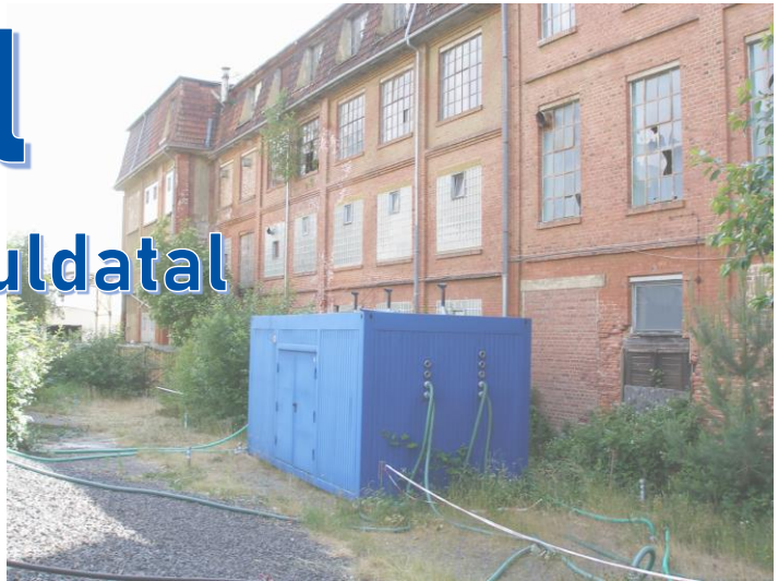
Bodenluftsanierung ehemaliges Betriebsgelände
