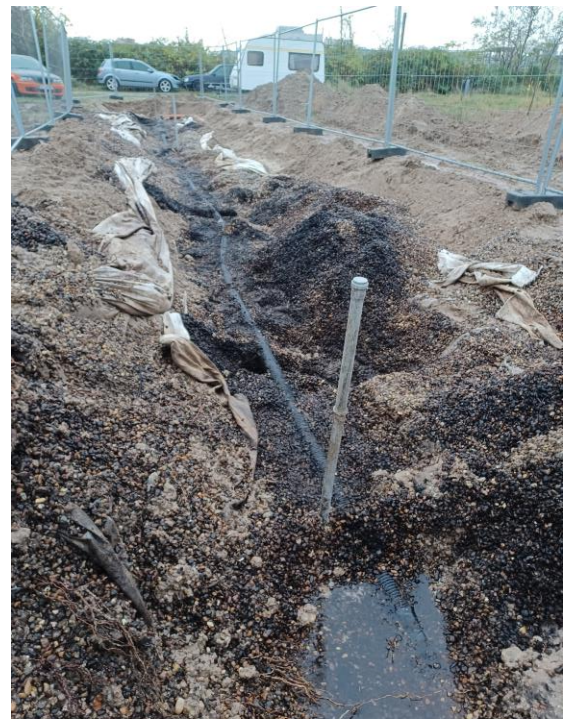
Mikrobiologische Zusetzungen in Sickerwasserrigole
