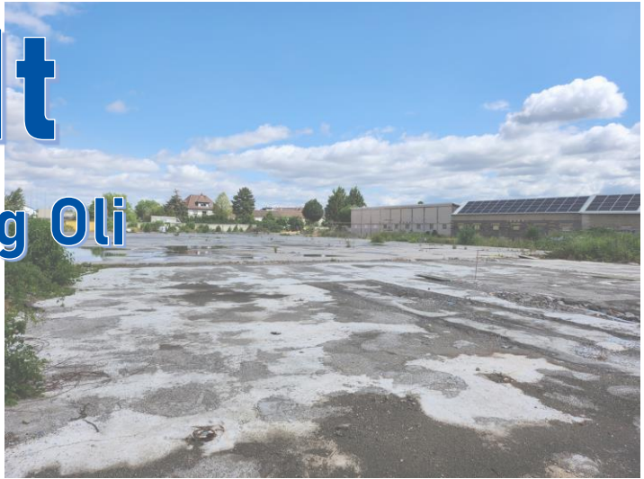
Werk II nach Gebäuderückbau, Juli 2023
