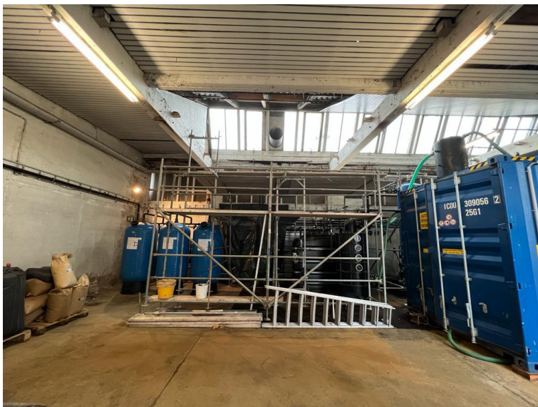
Reparatur am Hallendach
