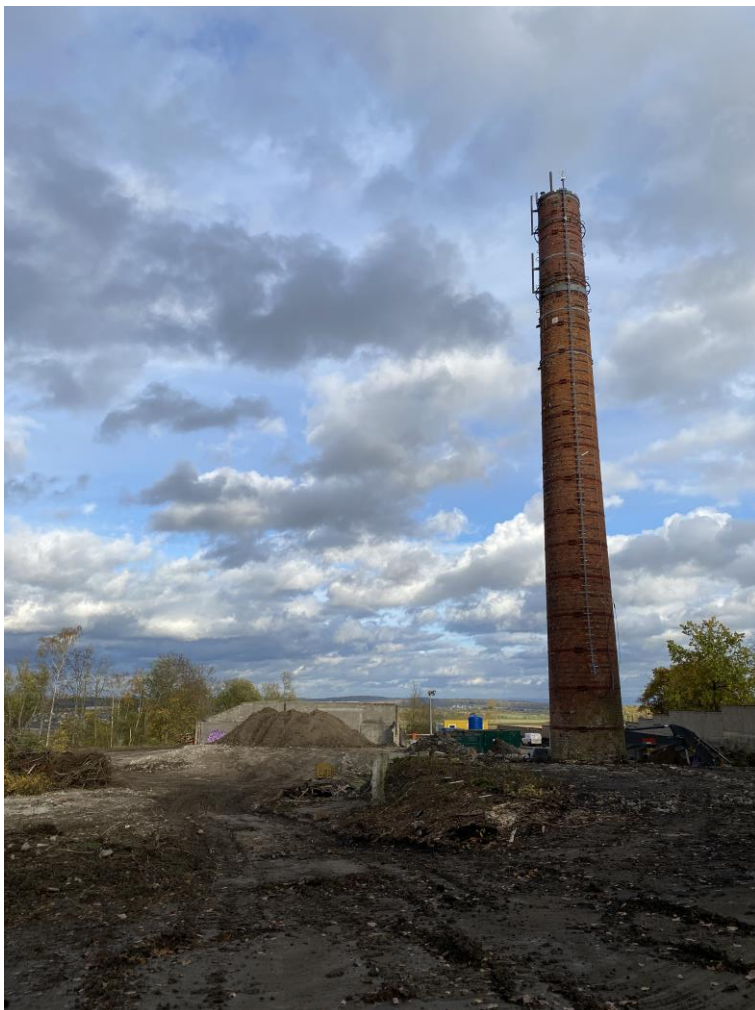
Betriebsgelände nach Gebäuderückbau
