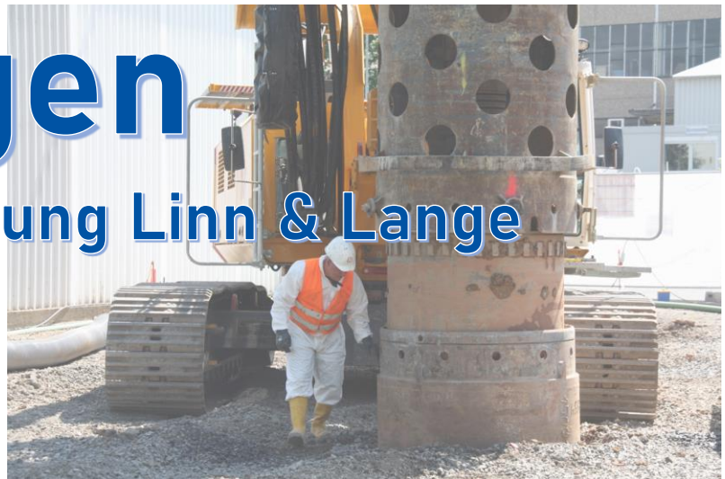
Großlochbohrungen (Sanierungsarbeiten 2012)
