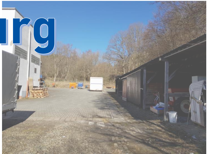
Blick entlang östlicher Grundstücksgrenze auf ehem. Lösemittelager
